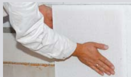
Applicare punti di collante con XPor-Malta Alleggerita e attaccare i pannelli.
